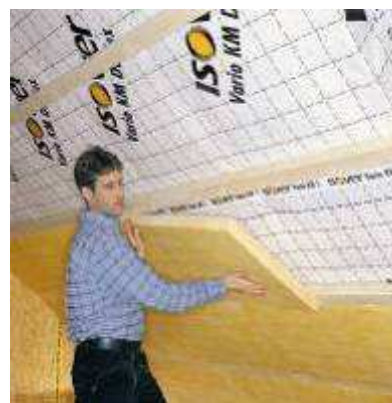
Закрепване на VARIO и запечатване на фугите
