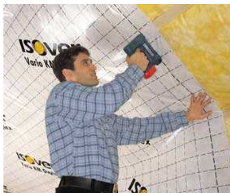
Закрепване на VARIO и запечатване на фугите
