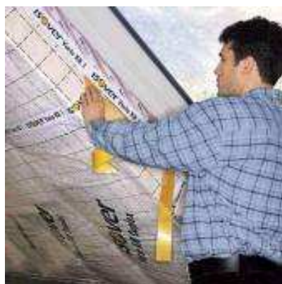
Закрепване на VARIO и запечатване на фугите
